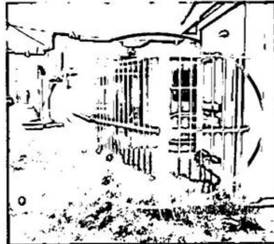
Rejas metálicas instaladas. Casa de Integración Familiar Apūshi – Bosa.
